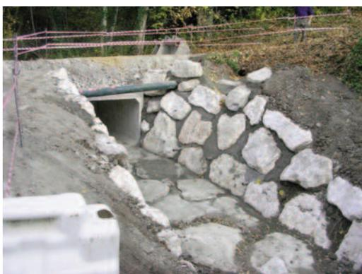
Le pont amont presque terminé est en attente du revêtement enrobé. Le pont aval est terrassé, les enrochements et la pose des cadres béton sont en cours.
