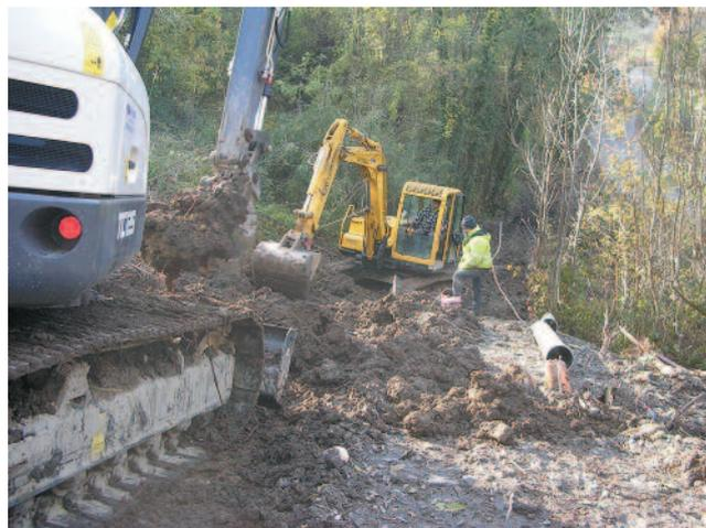
Les travaux ont débuté le 4 novembre pour une durée prévue de deux mois. Ils sont réalisés par la même entreprise. La conduite d'eau potable entre Les Rojons et Répidon vient d'être remplacée, ce qui permettra la mise aux normes incendie du secteur de Saint-Maximin-le-Vieux et d'une partie de Répidon. Ils se poursuivent par l'enfouissement des lignes aériennes et l'achèvement du réseau d'assainissement dans le hameau des Rojons. Coût de l'opération : 208 700 € TTC. ■
