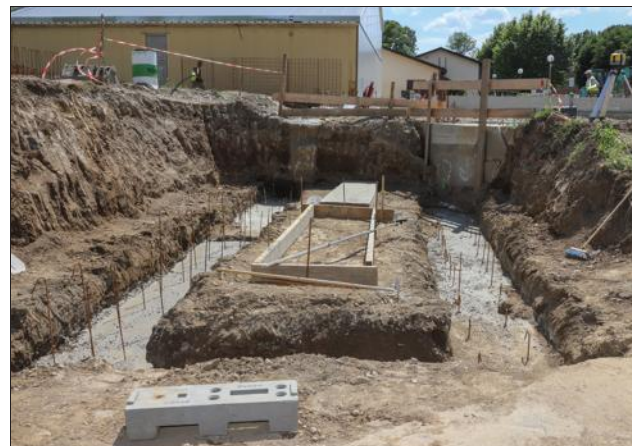
Près de 100 tonnes de béton ont été nécessaires à la réalisation des fondations de la médiathèque.
