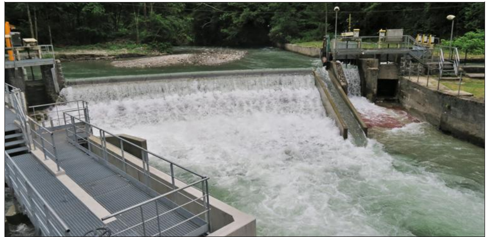
Les deux ouvrages de montaison et de dévalaison sur le barrage de Détrier assurent désormais la continuité écologique, en clair les allées et venues des petits poissons. Photo Le DL/Emmanuelle DUFFEAL
