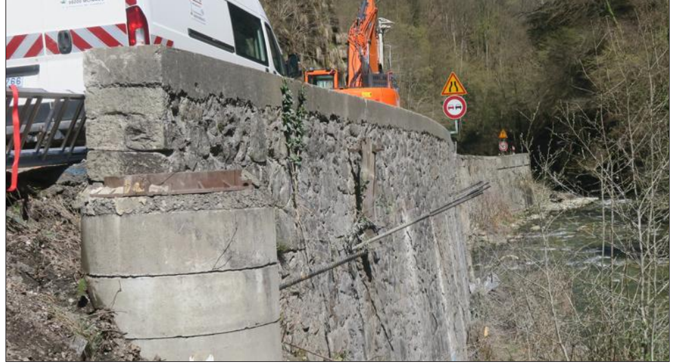
Les travaux actuels consistent à réparer les murs de soutènement du pont de la Noue, sur une longueur de 900 mètres, par un système d'ancrage et de béton projeté sur les parties les plus dégradées par l'eau qui a créé des cavités sous le mur. Les techniciens vont intervenir directement dans le lit du Bréda à partir du 15 avril. Photo Le DL/C.F.
